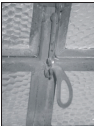
Figura 3. Conjunto de janelas basculante tomadas de ferrugem (E4) Fonte: Pesquisa de campo (2008)
